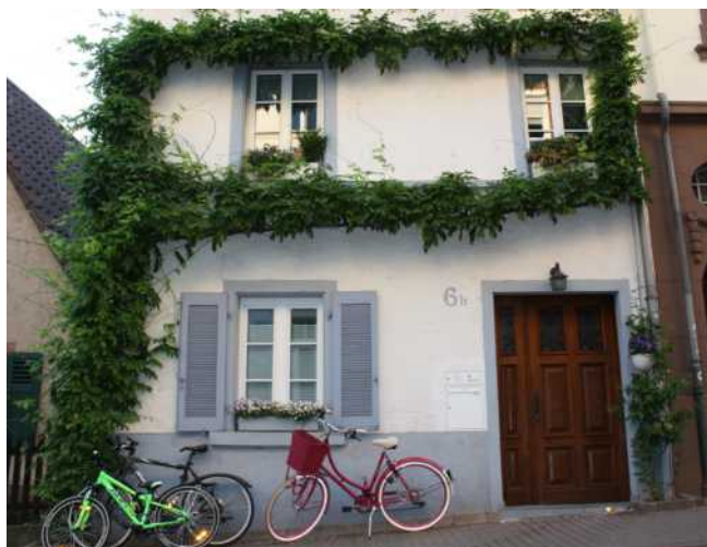
Abbildung 100: Fassadenbegrünung am Wohngebäude (Foto: ZSK TP1)
